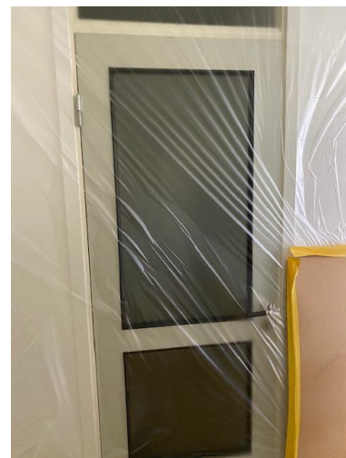
Bild 3: Inplastning av väggar
